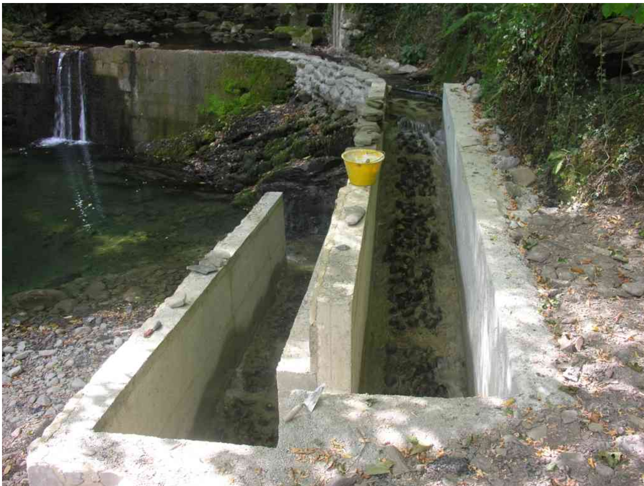
PARTICOLARE DEL FONDO DEL PASSAGGIO PER PESCI, CON CIOTTOLI FLUVIALI AFFOGATI NEL GETTO CEMENTIZIO
