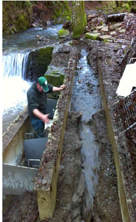
INTERVENTO DI RIPULITURA DELLA RAMPA DI RISALITA SUL RIO CEPPEA EFFETTUATO NEL MESE DI GENNAIO 2014
