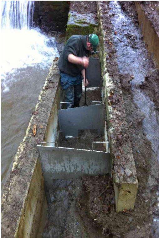
INTERVENTO DI RIPULITURA DELLA RAMPA DI RISALITA SUL RIO CEPPEA EFFETTUATO NEL MESE DI GENNAIO 2014
