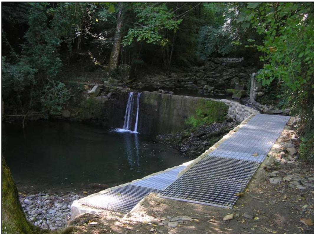
*Figura 24. Sbarramento sul torrente Trogola in località Molino della Sega dopo la costruzione del passaggio per pesci*
